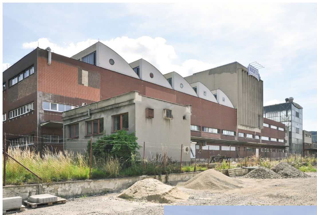
Obr. 1 Strakonice, Mlékárna a sušárna mléka (foto Jan Zikmund, 2011)
