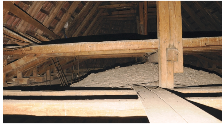
Obr. 7 Kotvy žeber na obr. 6 jsou nad klenbou zavěšeny do konstrukce krovu ocelovými pásky. Foto: 31. 10. 2011
