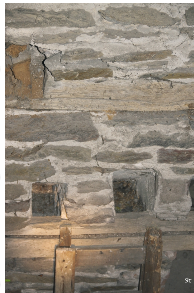
Obr. 9: Pařížov (okr. Chrudim), kostel sv. Maří Magdalény: a – pohled na východní stěnu věže v úrovni podkroví s nápadným rozhraním struktury románského zdiva, které svědčí o etapizaci výstavby kamenné věže, b, c – detail negativních stop po dřevěné konstrukci neznámého určení ve druhém patře věže (zaměření, kresba a foto M. Falta 2010–2011).
