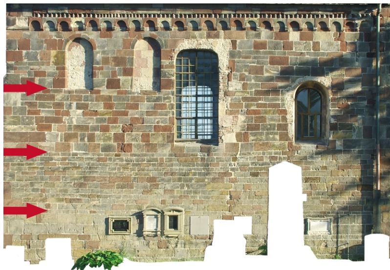
Obr. 2: Plaňany (okr. Kolín), kostel Zvěstování Panny Marie: Ortogonální fotografie pláště severní fasády lodi s vyznačením stavebních etap – šipkami vyznačeny technologické přestávky (foto M. Falta 2010).
