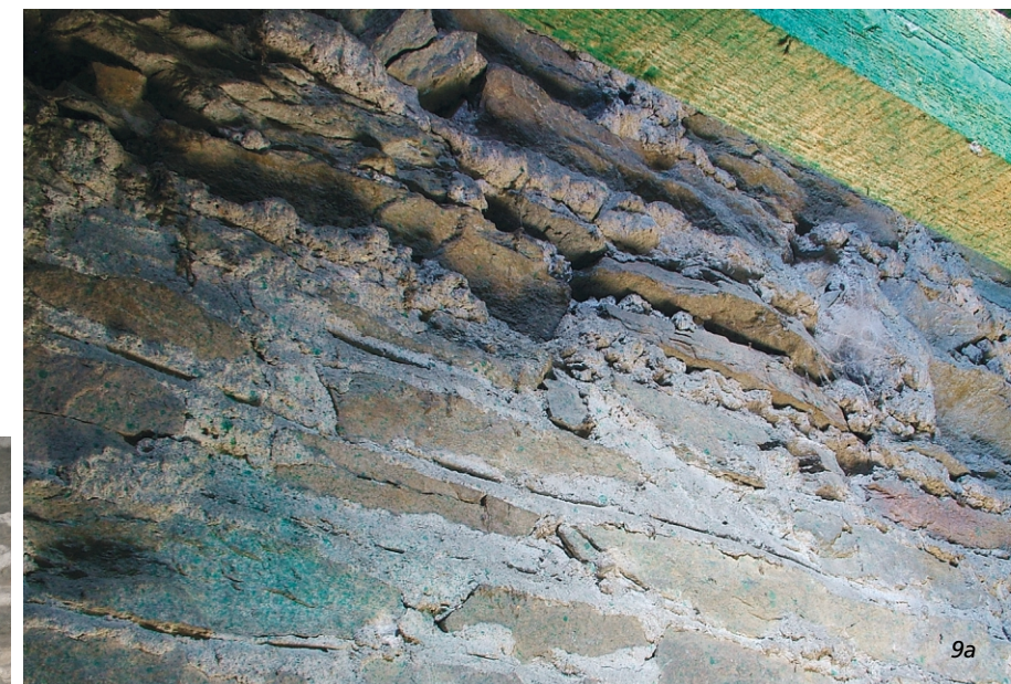
Obr. 9: Pařížov (okr. Chrudim), kostel sv. Maří Magdalény: a – pohled na východní stěnu věže v úrovni podkroví s nápadným rozhraním struktury románského zdiva, které svědčí o etapizaci výstavby kamenné věže, b, c – detail negativních stop po dřevěné konstrukci neznámého určení ve druhém patře věže (zaměření, kresba a foto M. Falta 2010–2011).
