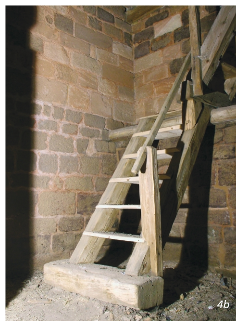
Obr. 4: Svojšíň (okr. Tachov), kostel sv. Petra a Pavla: a – východní strana věže v podstřeší lodi s patrným otiskem po někdejším západním štítu lodi; v polovině obrázku je patrné nápadné rozhraní struktury zdiva, které představuje přerušeni stavby po dokončení prvních dvou stavebních etap, b – vodorovná spára mezi červenohnědou arkózou a světlým pískovcem v rohu interiéru věže (v prostoru nad klenbou tribuny) v totožné niveletě jako rozhraní struktury zdiva na předchozím snímku (foto M. Falta 2008).
