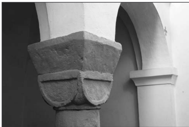
Obr. 4: Vysoký Újezd nad Dědinou (okr. Rychnov nad Kněžnou), kostel sv. Jakuba Většího. Krychlová hlavice nesoucí arkády empory (foto M. Falta 2011).
