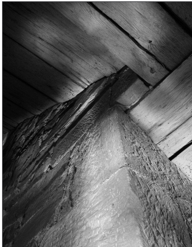
Obr. 10: Pařížov (okr. Chrudim), kostel sv. Máří Magdalény. Precizně opracované pískovcové bloky, které tvoří nároží na mezipodestě schodiště. Podesta je překryta hraněnými trámy, zatímco nad rameny schodiště se uplatňují fošny (foto M. Falta 2010).
