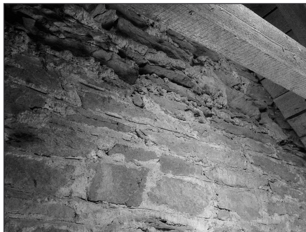
Obr. 15: Pařížov (okr. Chrudim), kostel sv. Máří Magdalény. Pohled z podkroví lodi na východní zeď věže s rozhraním mezi stěnou s rytými spárami ve spodní části a horním lomovým zdívem bez povrchové úpravy (foto M. Falta 2010).
