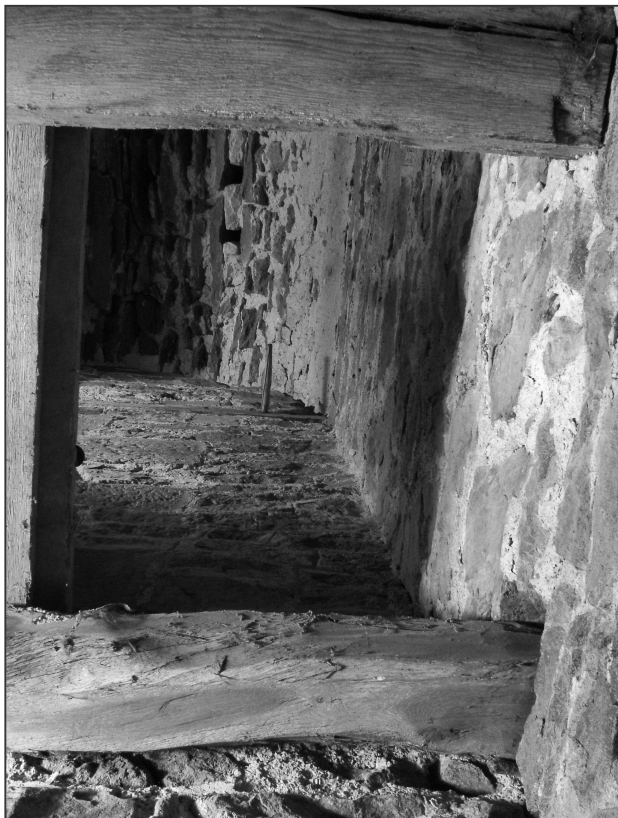
Obr. 6: Pařížov (okr. Chrudim), kostel sv. Máří Magdalény. Podlaha a klenba místnosti v prvním patře věže. Ve valené klenbě jsou patrné čtvercové otvory neznámého účelu (foto M. Falta 2010).
