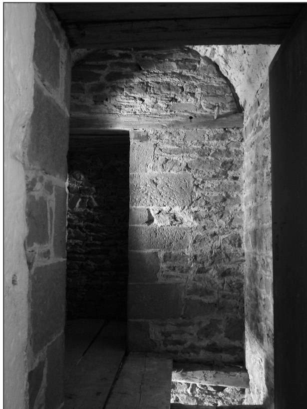
Obr. 7: Pařížov (okr. Chrudim), kostel sv. Máří Magdalény. Prostor v prvním patře věže. Pohled od vstupu z empory k dnes zazděnému portálu vedoucímu do exteriéru. V čele místnosti je zřetelná kombinace precizně opracovaného pískovce, zdiva z rulových desek s podřezávanými spárami a povalového stropu z dřevěných hraněných trámů (foto M. Falta 2010).
