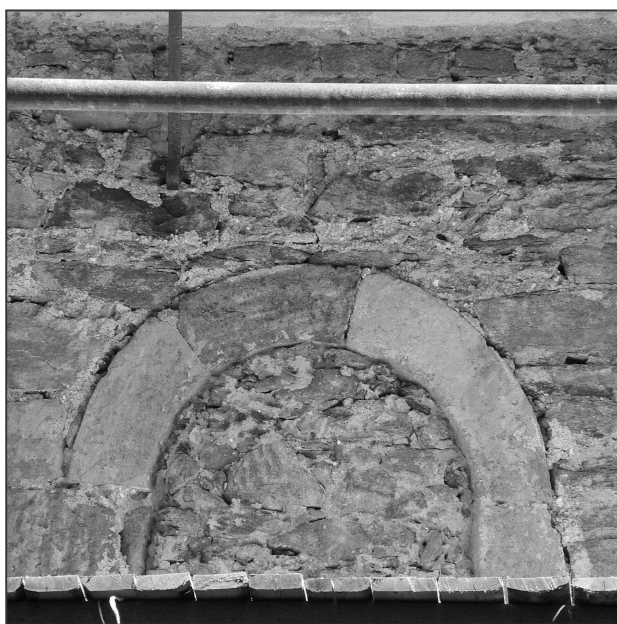
Obr. 4: Pařížov (okr. Chrudim), kostel sv. Máří Magdalény. Archivolta východního románského špaletového okna na jižním průčelí lodi (foto M. Falta 2010).
