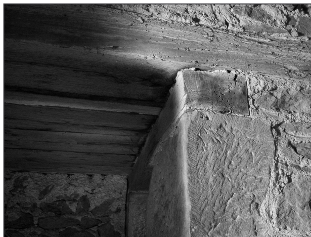
Obr. 8: Pařížov (okr. Chrudim), kostel sv. Máří Magdalény. Povalový strop z dřevěných hraněných trámů nad chodbičkou v západní zdi a kamenné ostění s dřevěným překladem portálu vedoucího ke schodišti v tloušťce zdi. Na stěnách místnosti z rulových desek jsou viditelné podřezávané spáry. V pozadí se nachází zazdívka románského portálu (foto M. Falta 2010).
