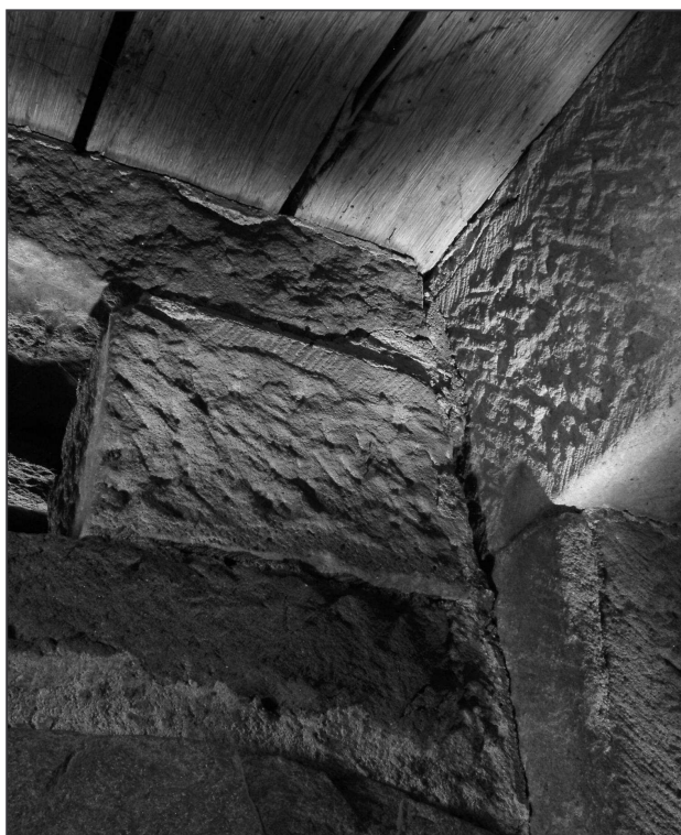
Obr. 11: Pařížov (okr. Chrudim), kostel sv. Máří Magdalény. Detail kamenného ostění a překládu portálu vedoucího ze schodiště do druhého patra věže. Strop nad podestou je tvořen hraněnými trámy (foto M. Falta 2010).
