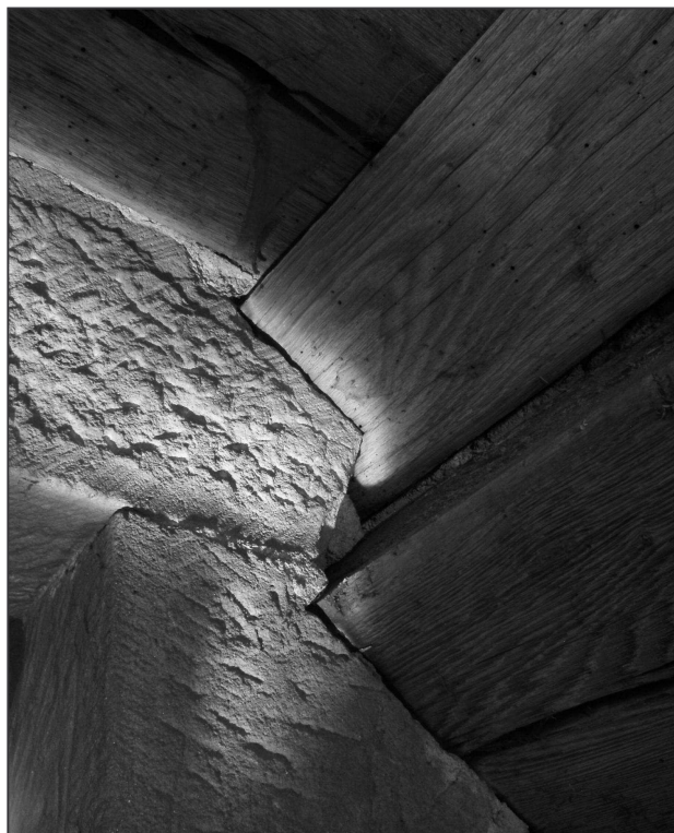
Obr. 12: Pařížov (okr. Chrudim), kostel sv. Máří Magdalény. Kamenné ostění a překlád portálu vedoucího ze schodiště do druhého patra věže a detail dřevěné zastropující konstrukce nad výstupním ramenem schodiště a podestou (foto M. Falta 2010).
