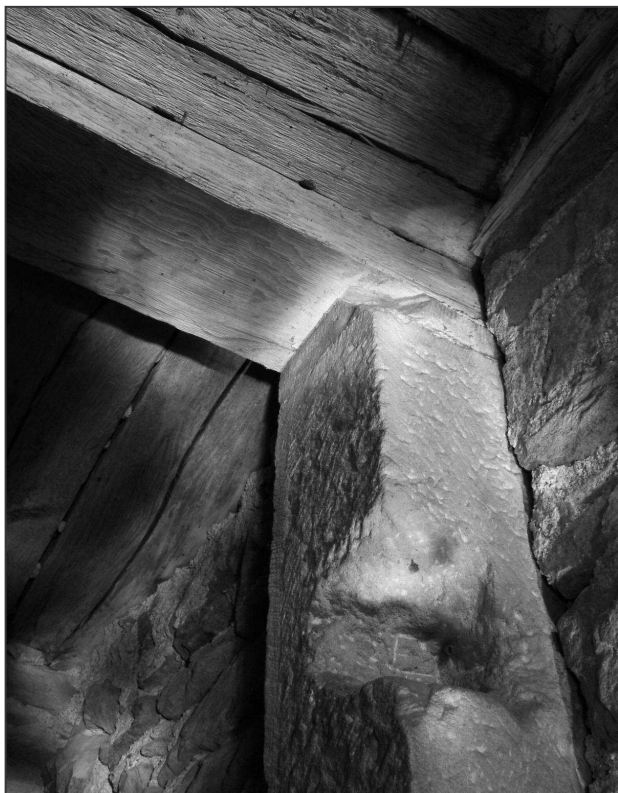
Obr. 9: Pařížov (okr. Chrudim), kostel sv. Máří Magdalény. Kamenné ostění a dřevěný překlád portálu spojující chodbičku v západní zdi se schodištěm v šířce zdi (foto M. Falta 2010).
