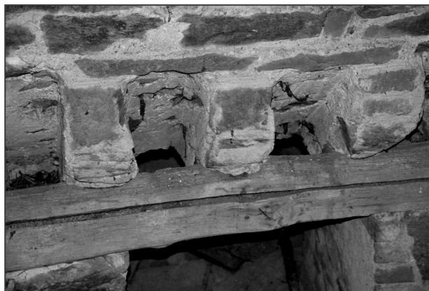
Obr. 14: Pařížov (okr. Chrudim), kostel sv. Máří Magdalény. Detail otisku po neznámé šikmé konstrukce a podkladní hraněný trám ve druhém patře věže (foto M. Falta 2010).
