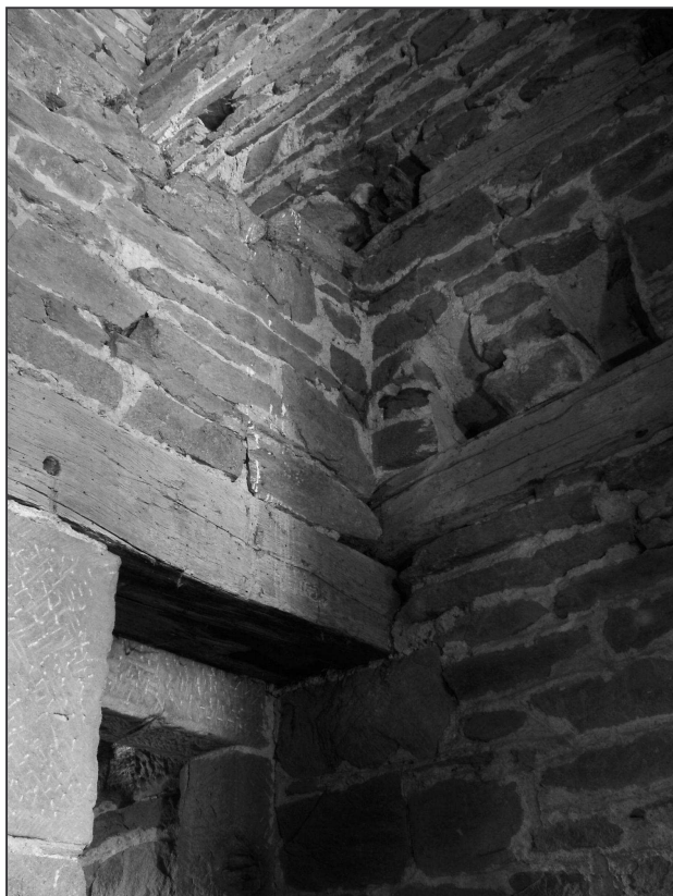
Obr. 13: Pařížov (okr. Chrudim), kostel sv. Máří Magdalény. Překlad portálu vedoucího ze schodiště do druhého patra věže a stopy po dřevěné konstrukci, jejíž význam nebyl doposud přesvědčivě objasněn (foto M. Falta 2010).
