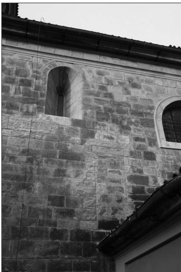
Obr. 5: Čelákovice (okr. Praha – východ), kostel Nanebevzetí Panny Marie. Pohled na románské okno, zazděný portál a barokní okno na jižní fasádě lodi (foto M. Falta 2010).
