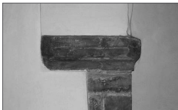
Obr. 7: Čelákovice (okr. Praha-východ), kostel Nanebevzetí Panny Marie. Hlavice přípory pod emporou (foto M. Falta 2010).
