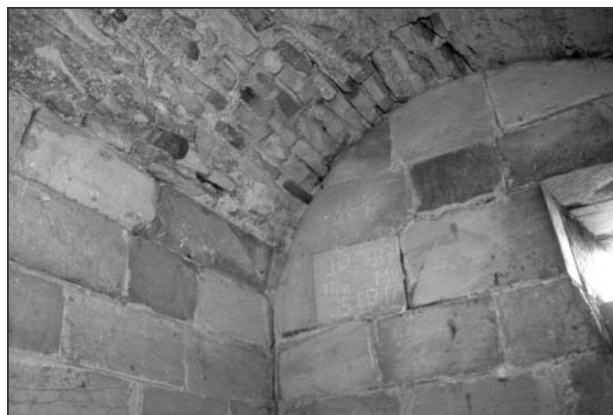
Obr. 13: Čelákovice (okr. Praha-východ), kostel Nanebevzetí Panny Marie. Detail skladby klenby kobky v předpokládaném druhém románském patře věže (foto M. Falta 2010).
