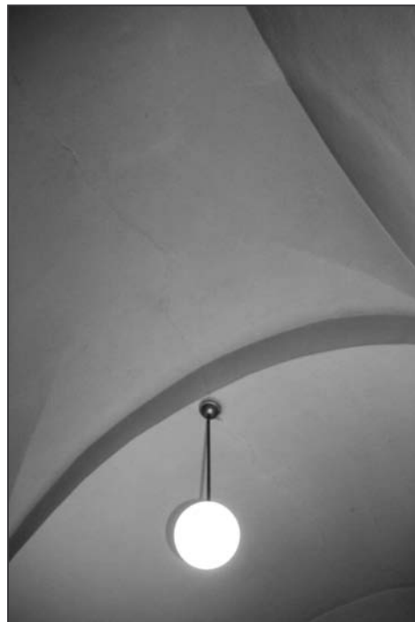
Obr. 11: Čelákovice (okr. Praha-východ), kostel Nanebevzetí Panny Marie. Pohled na vynášecí pas a klenbu v podvěžní kobce (foto M. Falta 2010).
