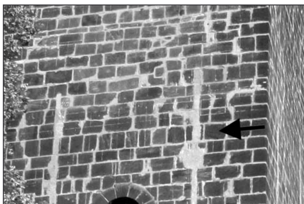
Obr. 19: Čelákovice (okr. Praha-východ), kostel Nanebevzetí Panny Marie. Fotografie vrchní partie západního pláště věže s vyznačením rozhraní struktury zdiva (foto M. Falta 2010).
