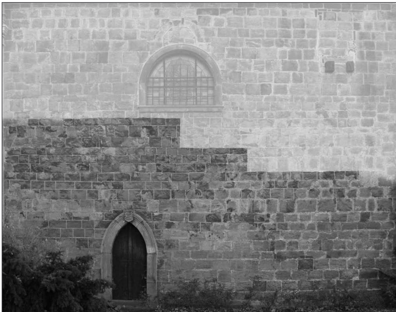
Obr. 18: Čelákovice (okr. Praha-východ), kostel Nanebevzetí Panny Marie. Fotografie severní fasády s vyznačením „schodovitého“ ukončení III. stavební fáze (foto M. Falta 2010).
